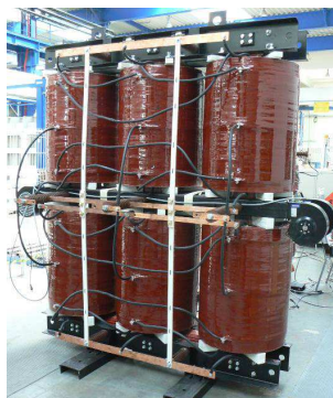
Transformator 24-pulsowy do zasilania przetwornicy częstotliwości 50/60Hz o mocy 1600kVA na napięciu sieci 15kV
