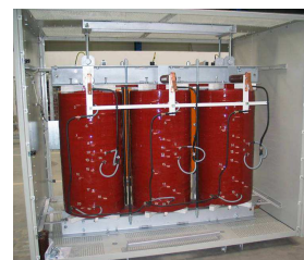
Transformator kompaktowy z prostownikiem do zasilania trakcji tramwajowej na napięciu 15kV o mocy 1200kVA.
