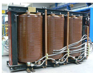
Transformator 2600kVA do stacji ognioszczelnej stosowanej w kopalniach węgla kamiennego na napięciu 6/3kV
