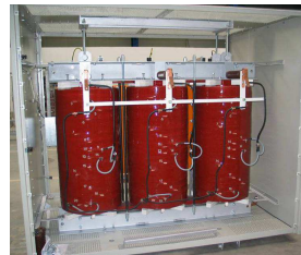
Компактный трансформатор с выпрямителем для питания трамвайной тяги напряжением 15кВ мощностью 1200кВА
