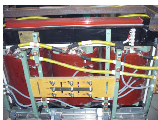
Трансформатор 400 кВА с внутренней циркуляцией воздуха для корпуса IP54 напряжением 6кВ
